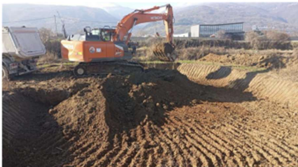
Фотографија 9: Делница 1 ископ за плочест пропуст
