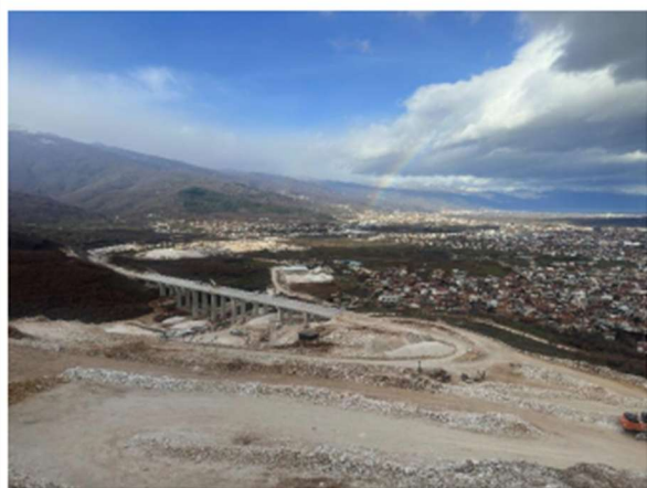
Фотографија 3: Делница 2 мост B0070
