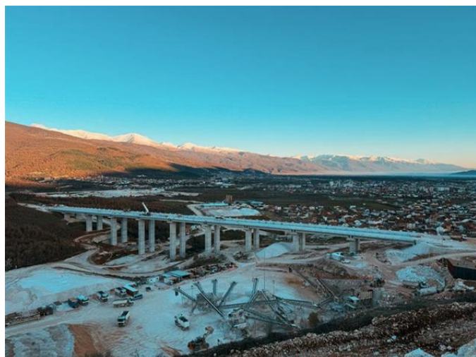
Фотографија 3: Делница 2 Мост B0070
