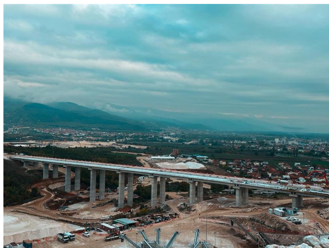
Фотографија 3: Делница 2 Мост B0070
