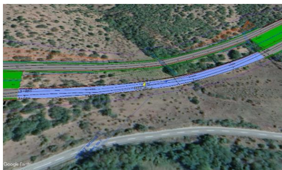
Мост 3 Десно (km 3+045.00 – 3+290.00)
