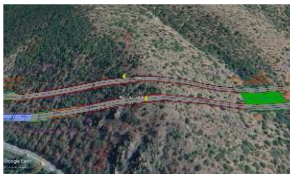
Тунел 1 лево (km 2+569.94 - 2+856.65) и десно (km 2+630.63 – km 2+860.00)
