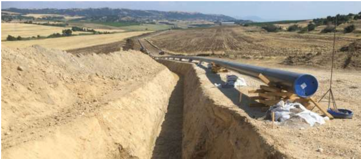
Слика 21-5 – Изградба на типичен гасовод
