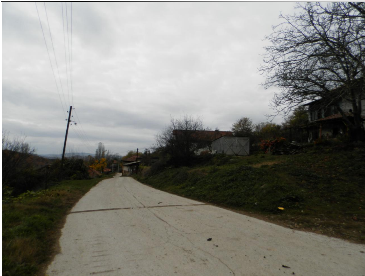
Слика 4 Поглед кон селото Турско Рударе од почетната точка на планираниот пат Р 1308 Почетниот дел од трасата се води низ силно еродиран терен. На следната слика е даден приказ на релативно стрмни падини нападнати од интензивни ерозивни процеси.
