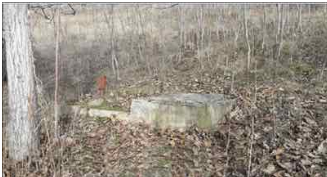
Слика 17: Комунални ресурси – Резервоар за вода во Т`лминци (Извор: Борис Стипцаров)
