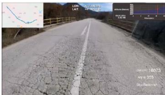
Слика 5 Мостовите на соодветниот дел се без соодветен систем за задржување и заштита
