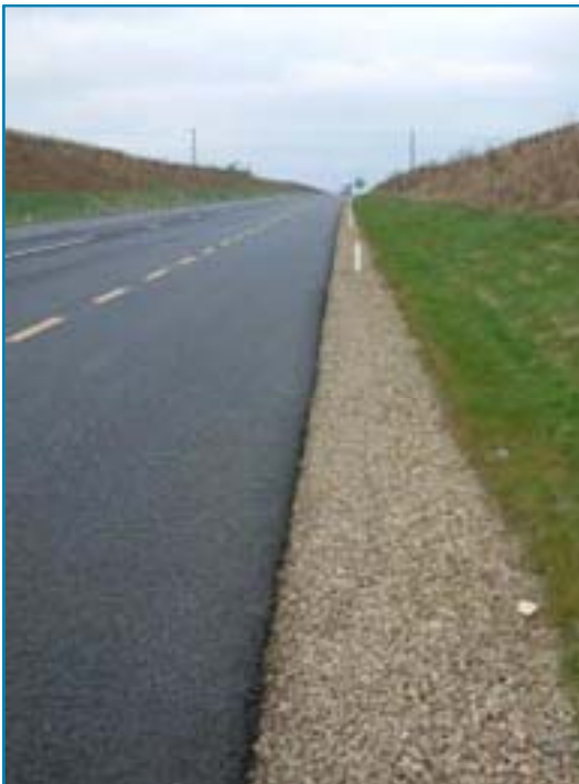
Figure 46 Пример за примена на таканаречена Француска дренажа
