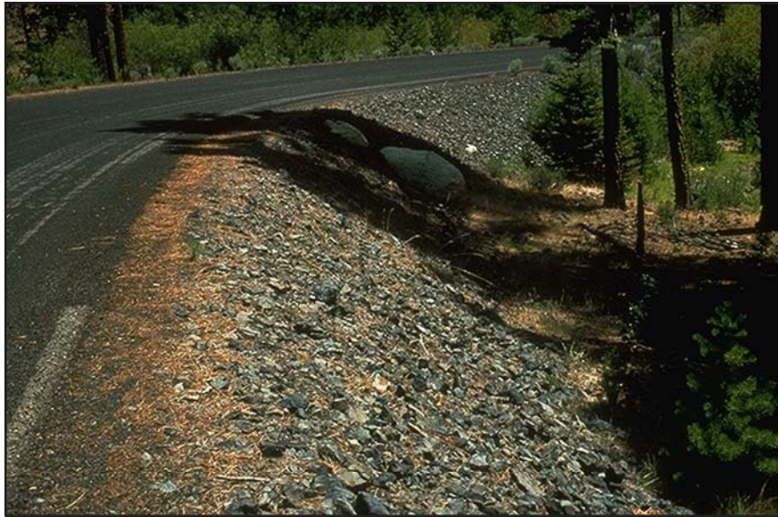
Слика 43 Облагање на насип со чакал и камен
