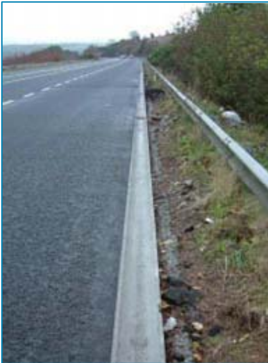
Figure 45 Систем за дренажа составен од риголи
