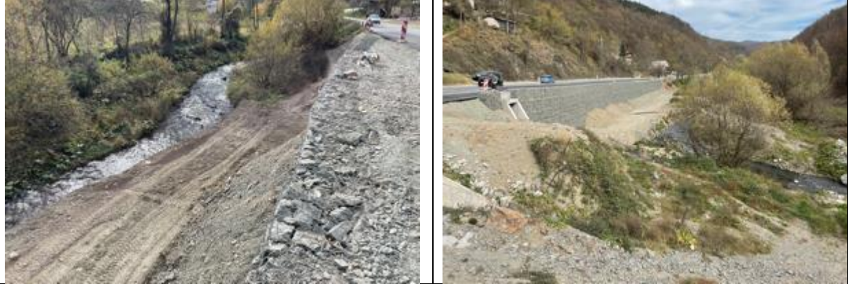
Слика 13 и 14. Изградба на потпорни ѕидови Figure 13 and 14. Construction of the retaining walls
