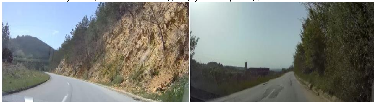
Слика 1. Одрони/слегувања на почетокот на делницата
